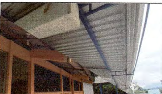
FOTO 9: Sustitución de canal de metal y Reparación de bajada de agua pluvial, tubo PVC 3" en modulo de patio
