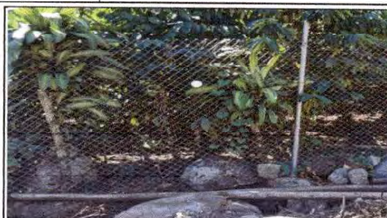
FOTO 14: Reparación de tubo hg y malla galvanizada en modulo de patio
