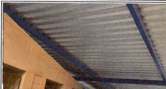
FOTO 1: Sustitución de lámina, por lámina troquelada aluzinc calibre 26 y Sustitución de estructura de soporte de madera, por metal. Sanitarios
