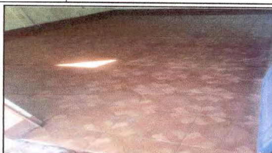
FOTO 8: Sustitución de piso de torta de concreto por piso cerámico (AULA 1,2,3 y4)
