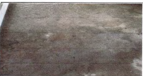
FOTO 17: Reparación de planchas de concreto en modulo de patio
