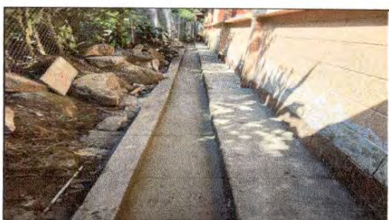
FOTO 10: reparación de cuneta de concreto. en Modulo de patio
