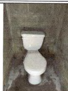
FOTO 2: Sustitución de piso de torta de concreto por piso cerámico, Sustitución inodoro y Sustitución de Azulejo, en modulo de baños
