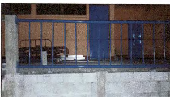
FOTO 16: Sustitución de baranda de madera por baranda de metal. Modulo de patio
