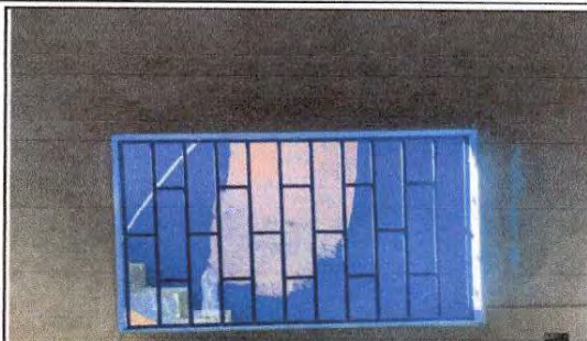
FOTO 7: Fabricación e instalación de balcones de hierro en ventana aula 4
